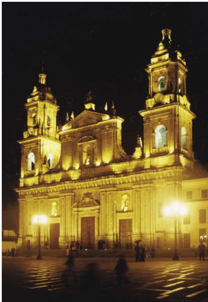
PROYECTOS DE ILUMINACIÓN EN COLOMBIA
