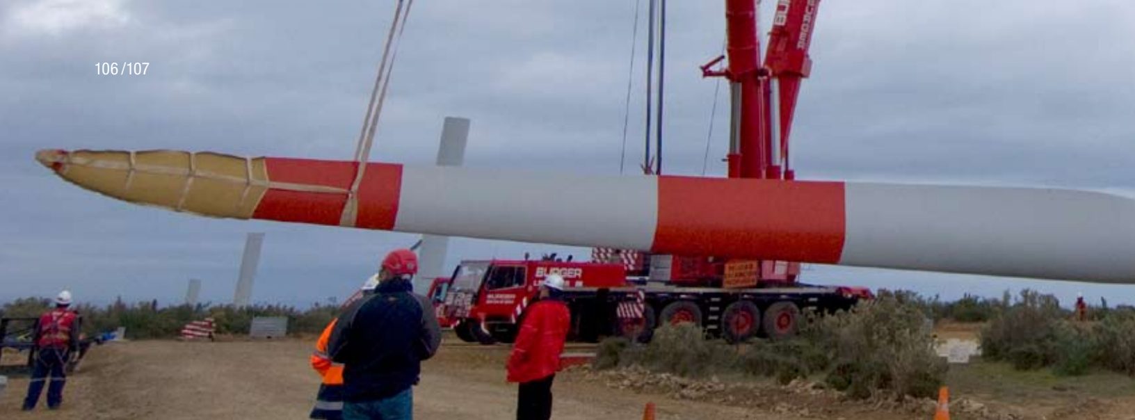
Montaje, Parque Eólico Canela.
