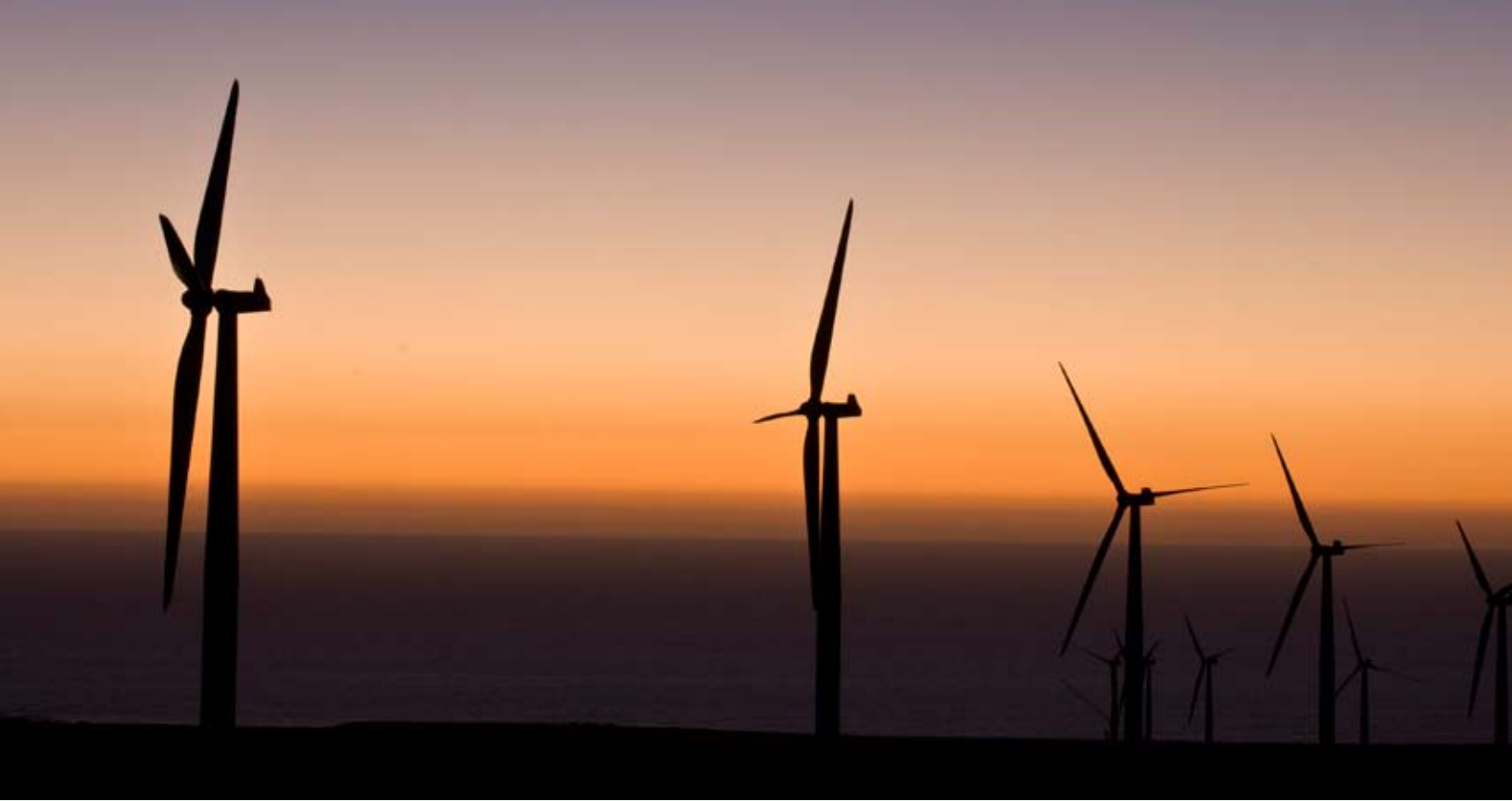
Parque Eólico Canela.
