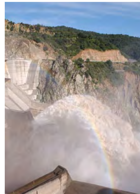
Central hidroeléctrica Rapel, Chile.
