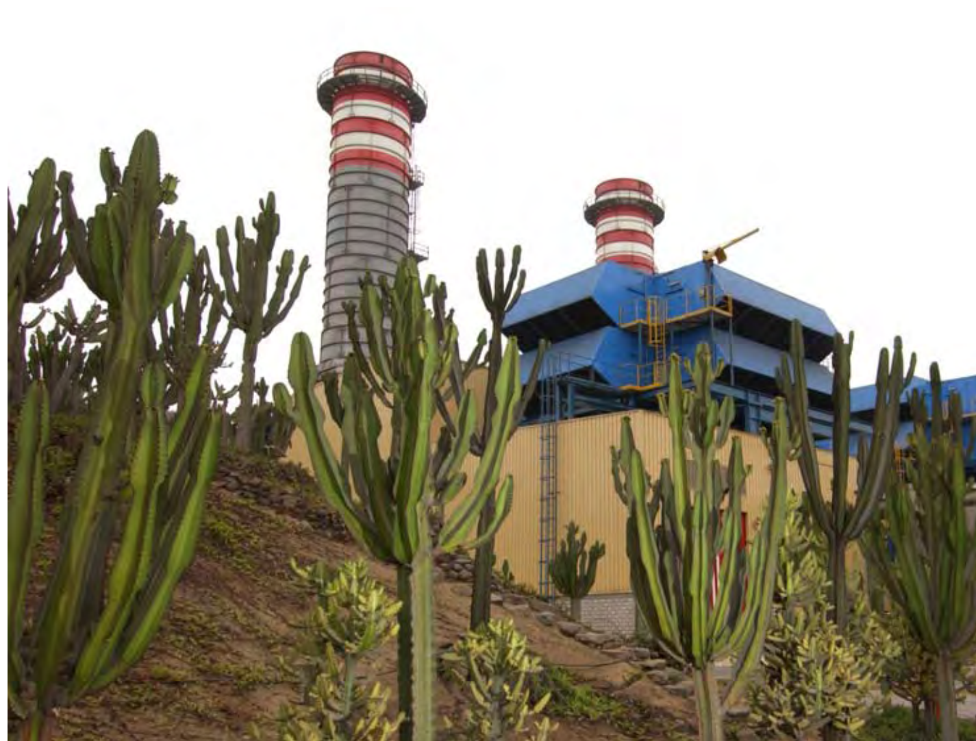
Central termoeléctrica Ventanilla, Perú.
