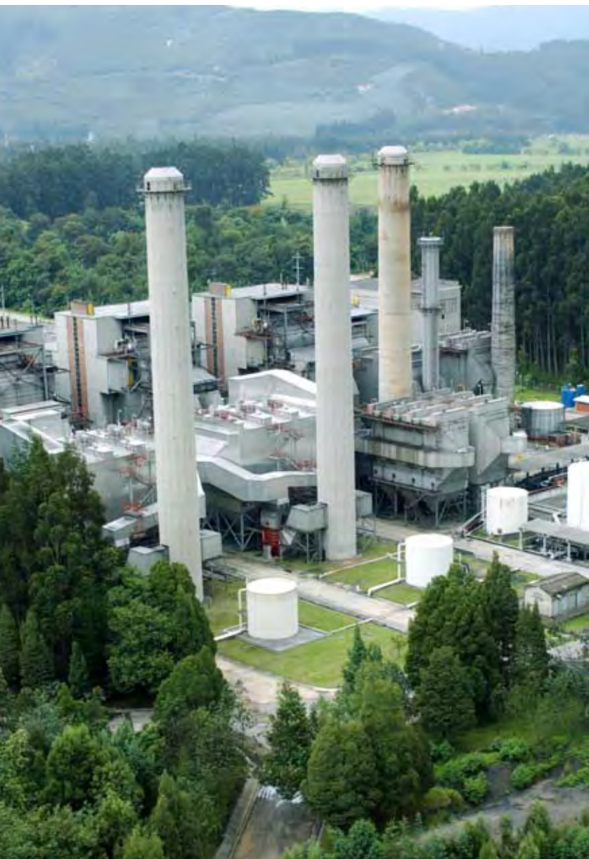
Central térmica Termozipa, Colombia.
