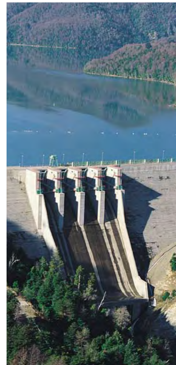
Central hidroeléctrica Pangué, Chile.
