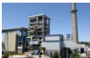
BOCAMINA II 370 MW REGIÓN DE BÍO BÍO, CHILE
