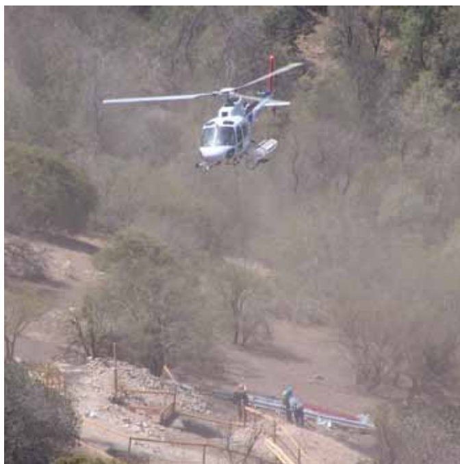
Montaje con helicóptero torre N° 5
