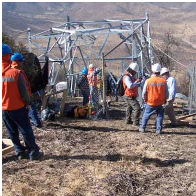
Montaje de estructuras de torre n° 9
